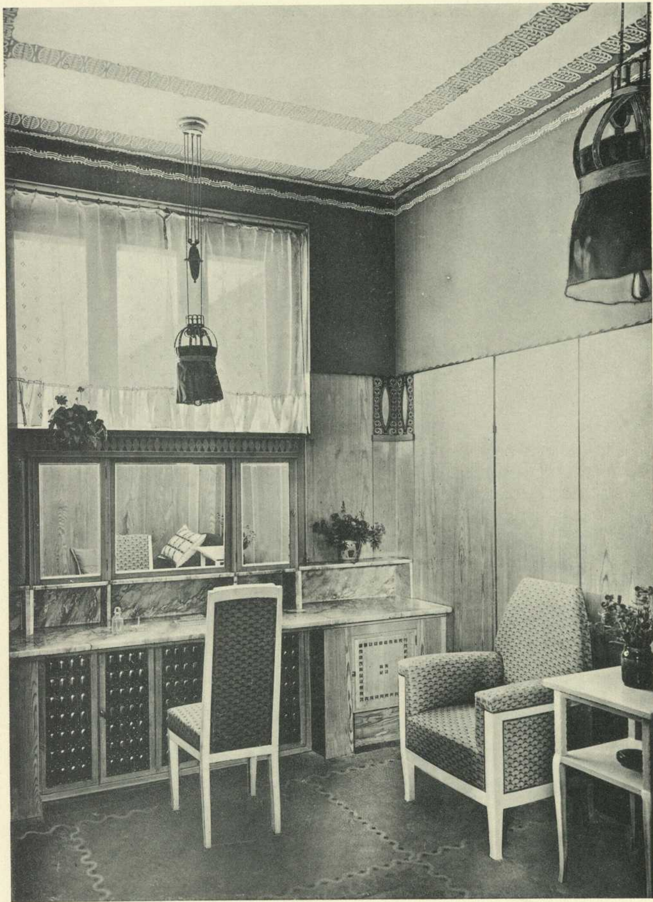
FÜRSTENBAD NAUHEIM, TOILETTEZIMMER
