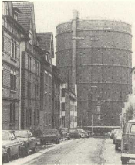
... und wo der Osten endet: das Stuttgarter Gaswerk.
