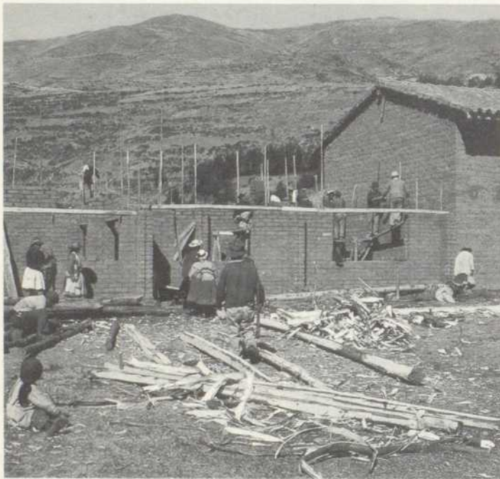
CRA Terre-Baustelle Peru: Errichtung einer Schule in Lehmstein
