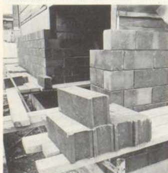
Lehmsteinblöcke vor dem Vermauern
