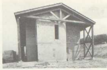
Projekt C Architekt: S.Jaure, F. Confino, J.P. Duval 4 WE in einem Gebäude (2x4Z., 2x5Z.) äußeres Tragwerk in Holz, Wände in pisé, Betondecken
