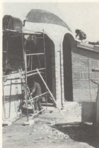
Eine Halbkuppel im Bau
