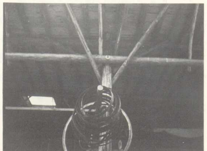
Rundholzständer mit Kopfbändern (Nordansicht)
