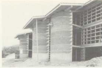
Projekt B Architekt: J.V. Berlottier 4 WE in einem Gebäude (2x4Z., 2x5Z.) Wände in pisé, Holzdecken
