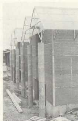
Projekt K interner Wettbewerb Architekt: F. Galard, L. Guibert 5 WE in einem Gebäude (2x4Z., 3x5Z.) Holzfachwerk, Wände in gepressten Erdbetonsteinen, Holzbalkendecken
