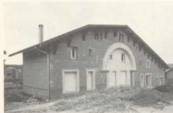
Projekt I Architekt: J.M. Savignat, O. Perreau- Hamburger, M. Munteanu 4 WE in einem Gebäude (2x4Z., 2x5Z.) und ein Einfamilienhaus Wände in pisé, Holzbalkendecken,
