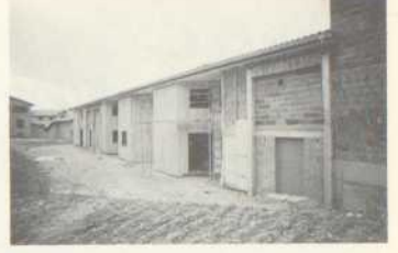
Projekt D Architekt: Groupe AURA 6 WE in einem Gebäude (3x4Z., 3x5Z.) Wände in Lehmstein, Betondecken
