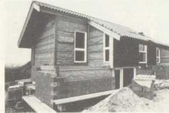
Projekt J Architekt: F. Galard, L. Guibert 5 WE in fünf Einzelhäusern Holzfachwerk, Wände aus gepressten Erdbetonsteinen, Holzbalkendecken
