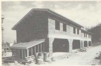
Projekt A Architekt: Groupe ERSOL 5 WE in einem Gebäude (2x4Z., 3x5Z.) Wände aus Lehmsteinen, Betondecken
