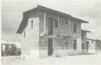
Projekt E Architekt: ATELIER 4, P. Wagner, N. Widmer, S. Theunynck 6 WE in Reihenhäusern (3x4Z., 3x5Z.) Wände in Holzfachwerk mit Leichtlehm- ausfachung, Holzdecken mit Lehm- schüttung
