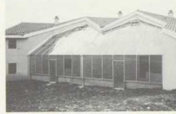
Projekt G Architekt: U. Moch, P. Carle, G. Chavance 5 WE in einem Gebäude (1x3Z., 2x4Z., 1x5Z., 1x6Z.) Wände in Lehmstein, Betondecken
