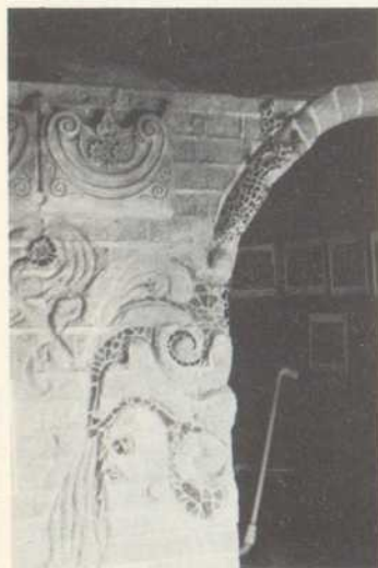
Ornamentierte, mit Mosaiken und Keramiken versehene Wand, die darüber hinaus selbst noch plastisch bearbeitet wurde. Die Weichheit des Lehmsteins ...
