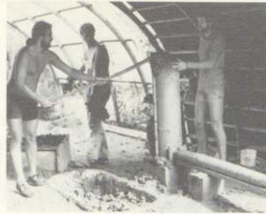
Lehmstränge: vorbereitet in Zwangsmischer und Strangpresse
