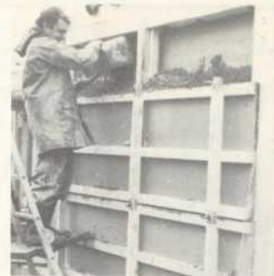
Schüttlehm: Einfüllen des wärmedämmenden Leichtlehms
