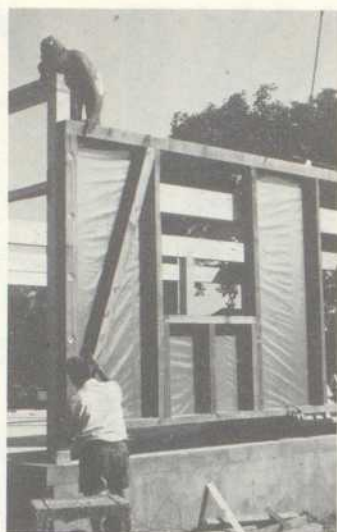
Versuchsbau: Anschlagen der vorgefertigten Tafeln an das Skelett
