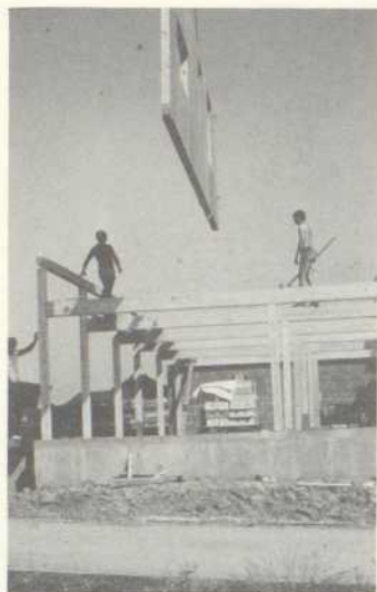
Versuchsbau: Geschosswiser Skelettaufbau
