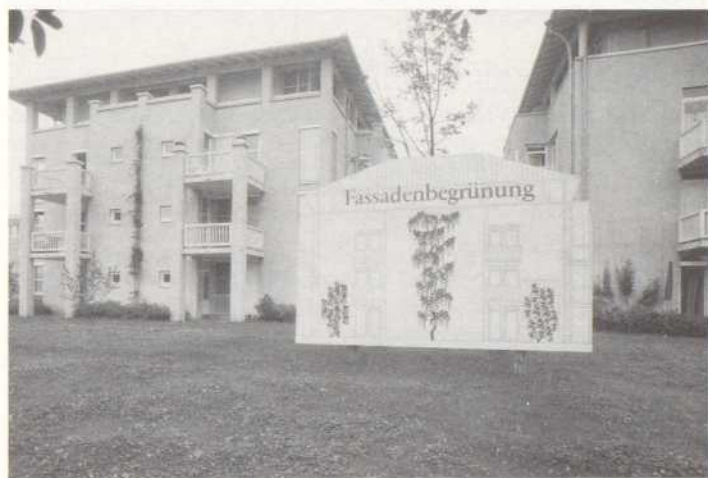
Begrünungsmaßnahmen in Betzenhausen
