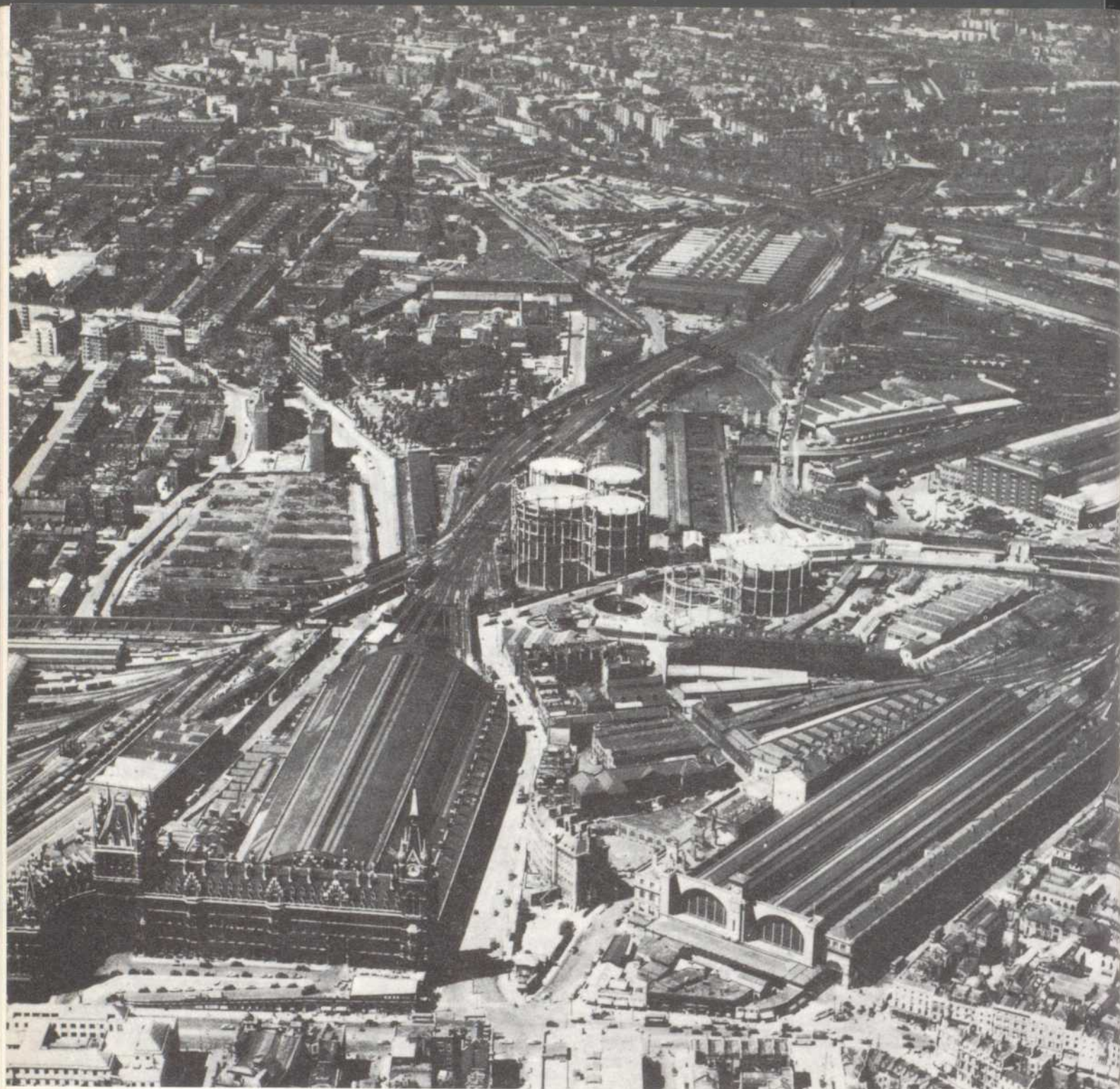
Das Gelände von Süden. Links St. Pancras Station, rechts King's Cross Station
