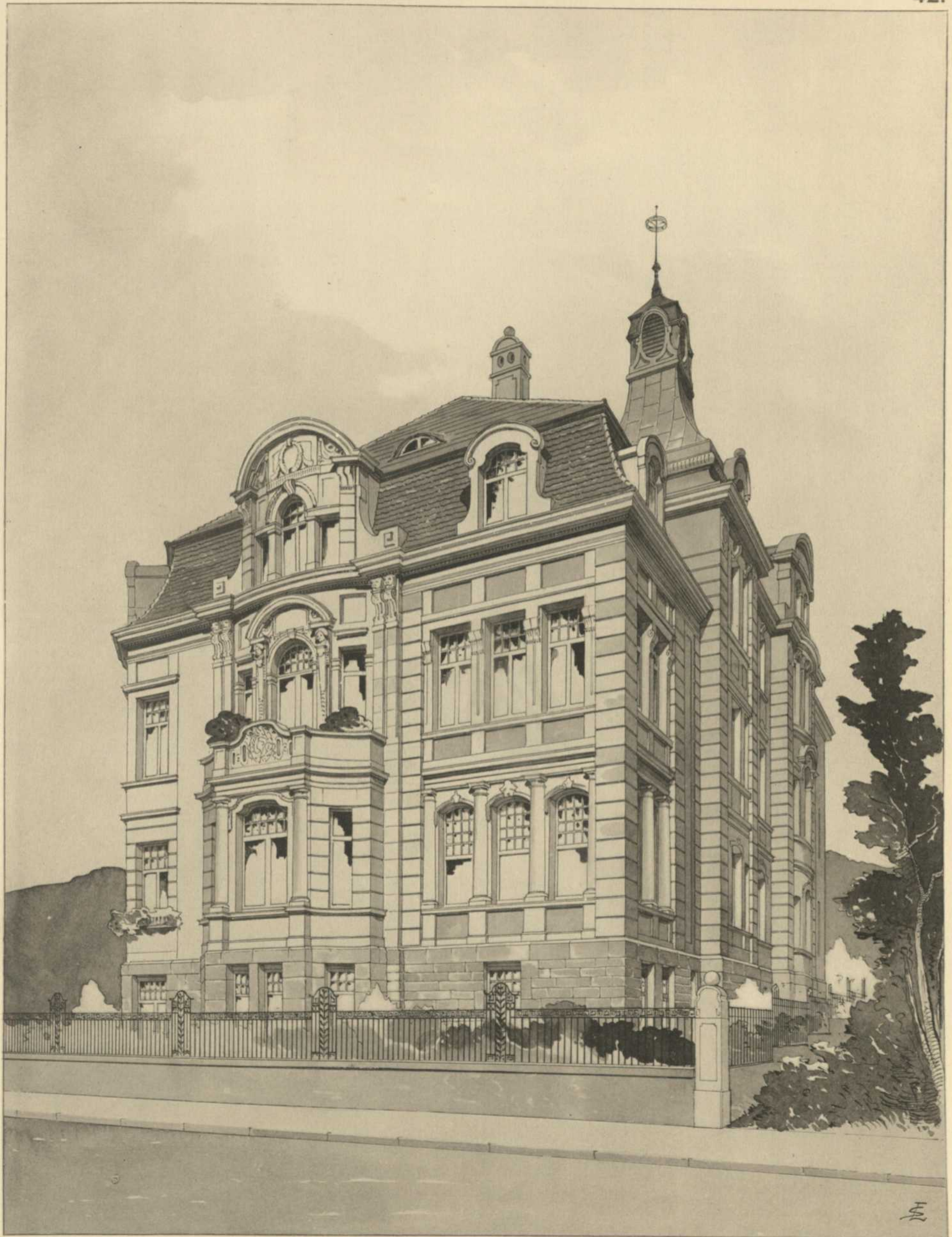
WOHNHAUS IN STUTTGART. ARCHITEKTEN: PROFESSOR P. SCHMOHL & G. STAEHELIN IN STUTTGART.
