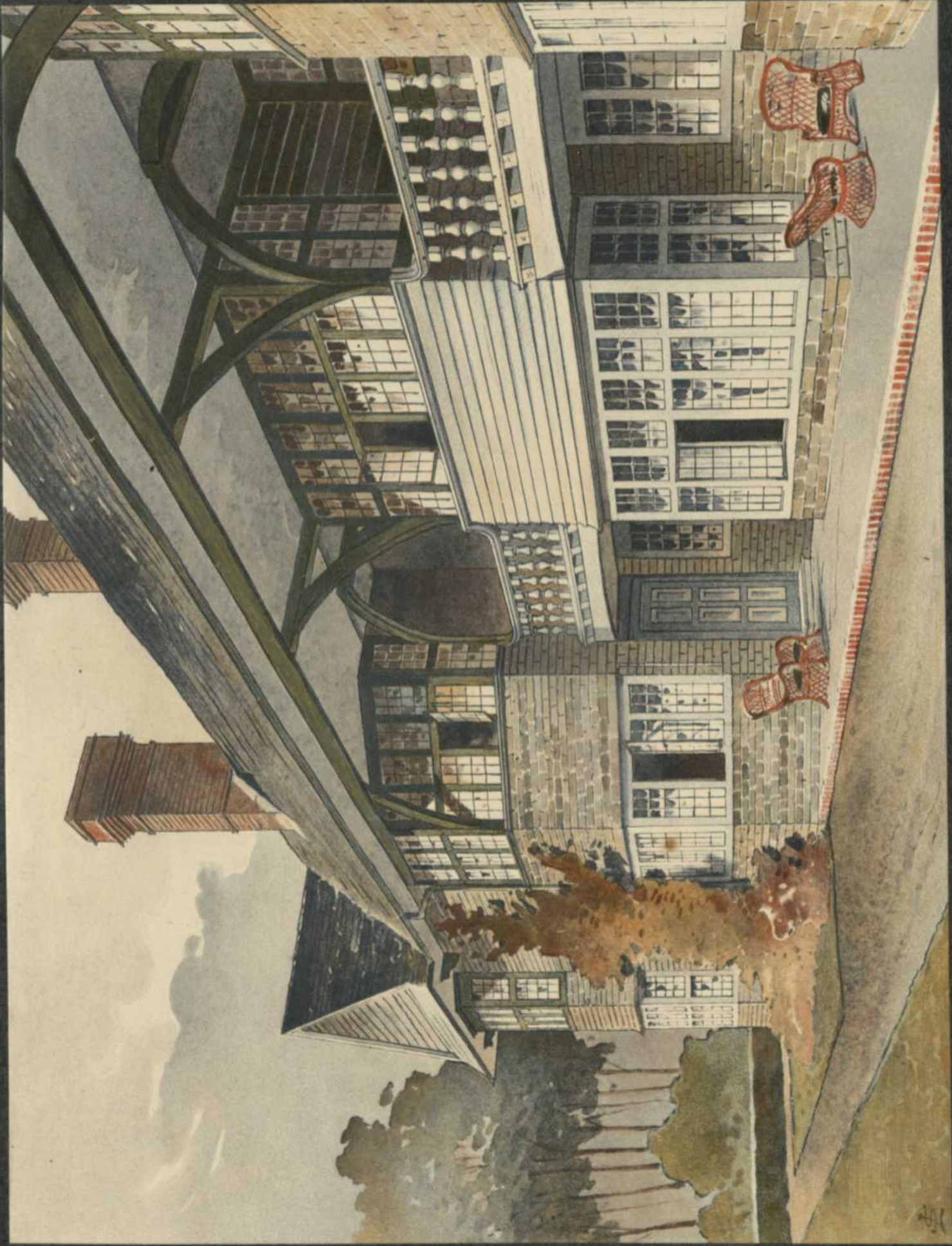
HAUS IN FULBROOK (ELSTEAD). ARCHITEKT: E. L. LUTYENS IN LONDON.
