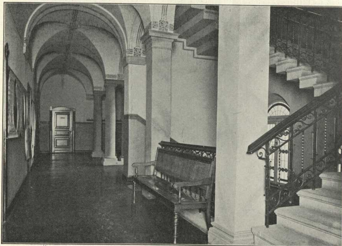
Mittlerer Flur im hüttenmännischen Gebäude.
