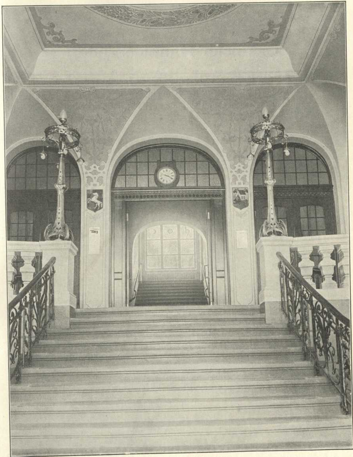
Treppenaufgang im Hauptgebäude.
