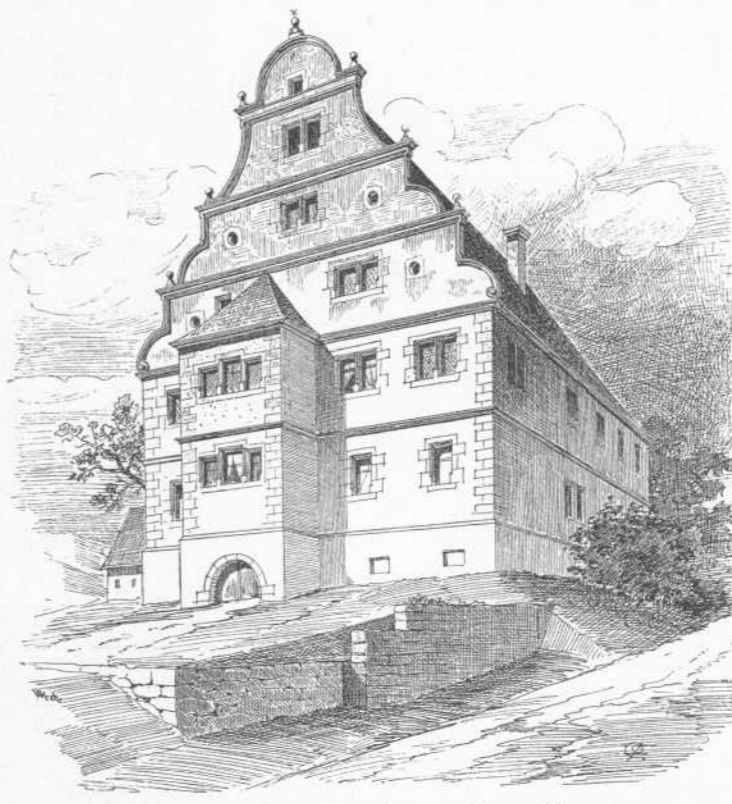
Zaberfeld. Haus der von Sternfels.
