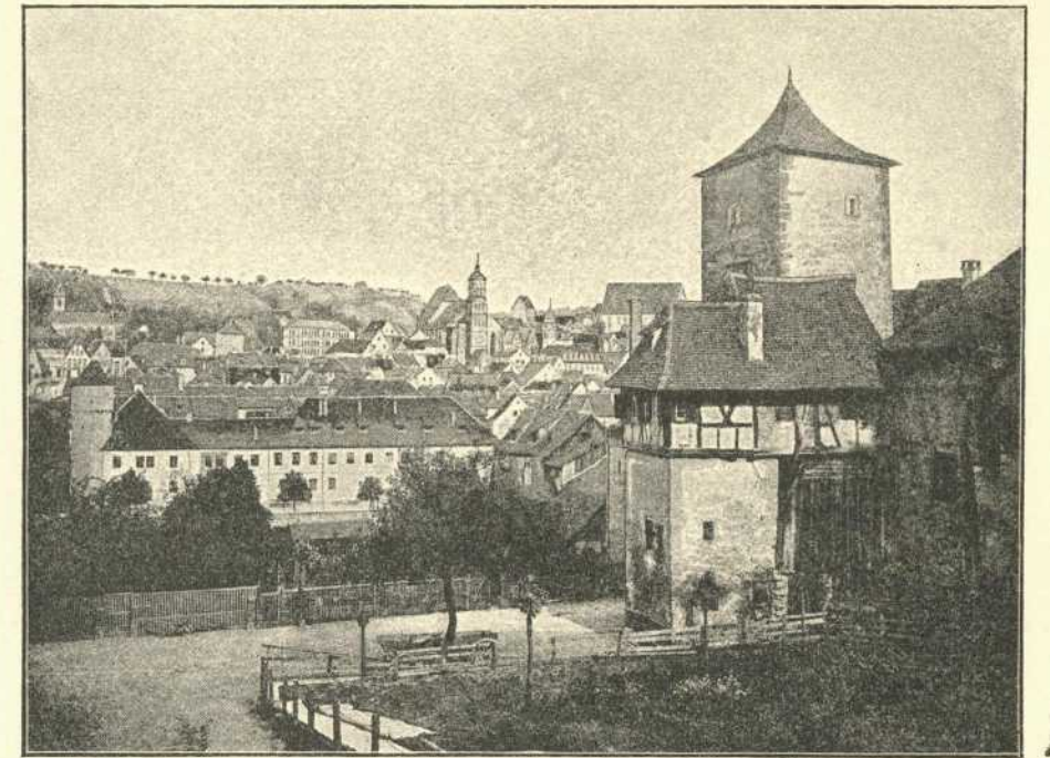
Hall von der Westseite.
